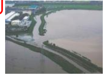
図：洪水被害の事例 (国土交通省中部地方整備局提供)
