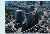
再開発を機とした地域冷暖房の導入
